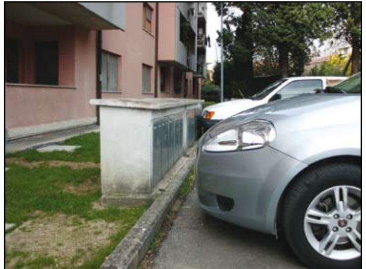
Siamo su pubblico parcheggio dove i contatori del gas sono a rischio "scontro". Ormai da qualche anno è stata divelta la protezione!
